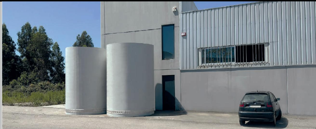
**DESCRIPCIÓN:** Tanque funcional para el almacenamiento de agua realizado con material eólico reciclado. Su composición supone garantía de resistencia.
